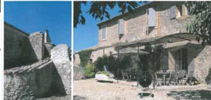
Vue de la façade Sud du corps principal et vue de détails de l'arrière du bâtiment principal. Ces photos montrent les matériaux existants
